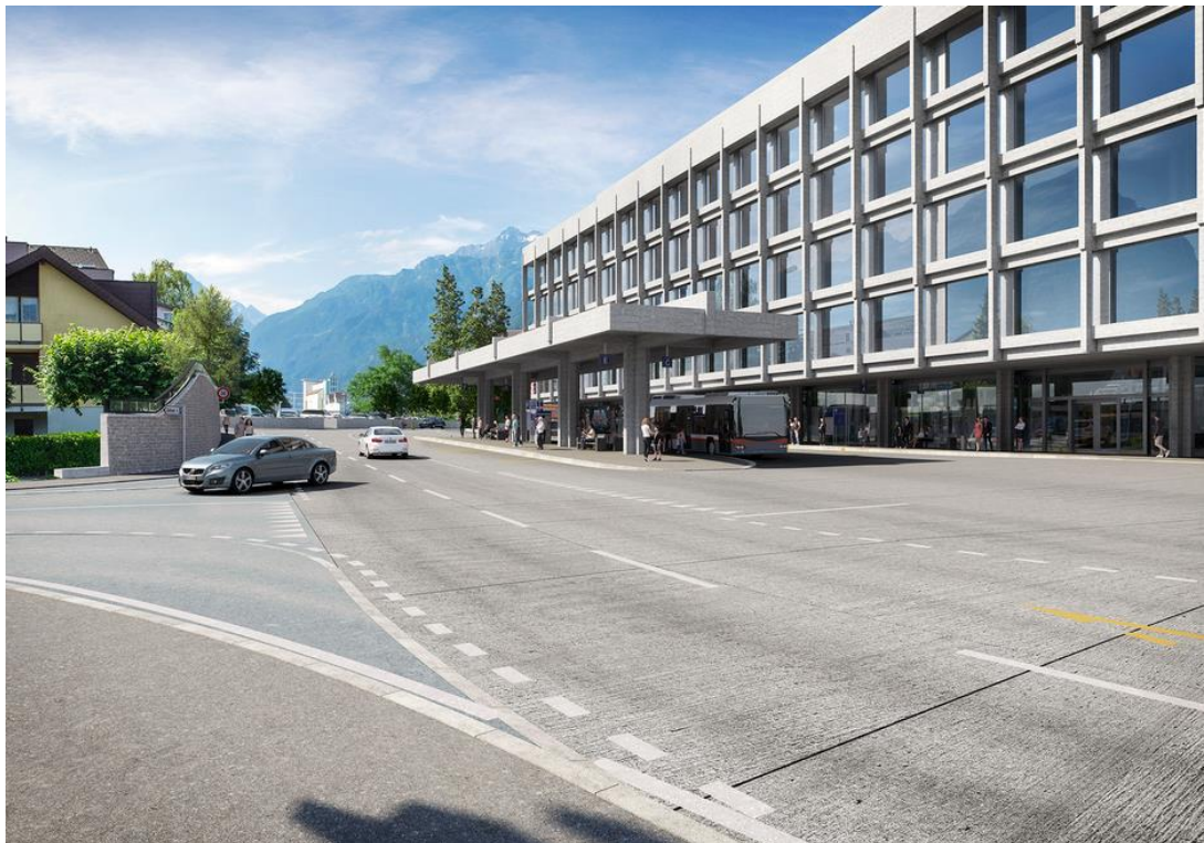
Abb. 1: Visualisierung der Ostansicht des neuen Kantonsbahnhof in Altdorf (Quelle: www.ur.ch ; Bild von Angel Sanchez)
